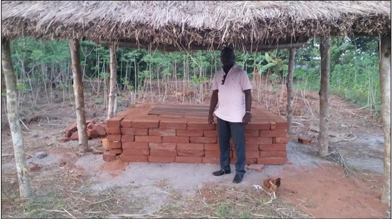
**Photo d'une chambre froide zéro énergie (ZECC) en cours de construction dans une ferme au Bénin par Guy Kodjogbe, membre du conseil d'administration du PEF**
