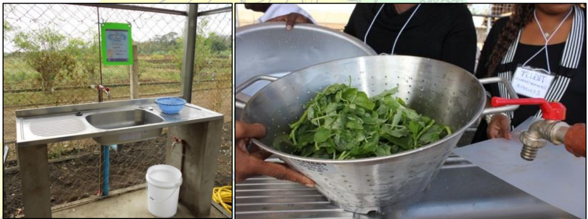
Fregadero de acero inoxidable y mostradores para lavar en el PTSC en Arusha, Tanzania.
