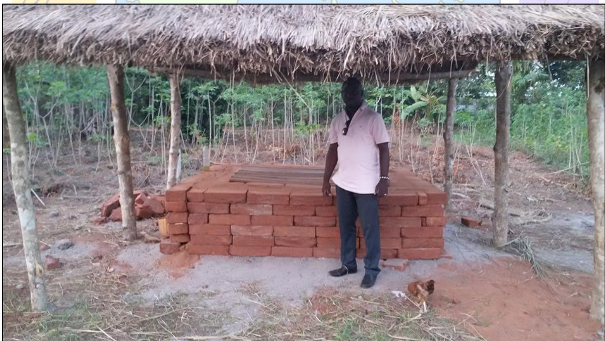
Foto de una Cámara Fría de Energía Cero (ZECC) siendo construida en una granja en Benin por Guy Kodjogbe, miembro de la junta de PEF
